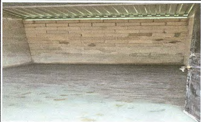
Foto 1: Preparando el terreno para el proyecto
